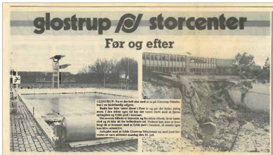
Billede af nedrivningen af Friluftsbadet
